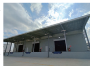
ベトナム初 日本品質の危険物倉庫
