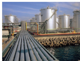
储罐场地事业
