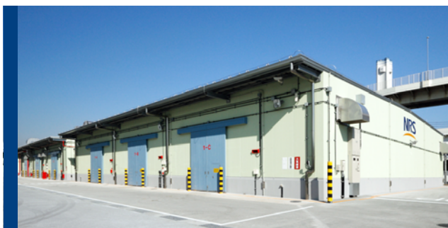
危険物倉庫（定温）
