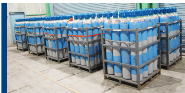
高圧ガス貯蔵所
