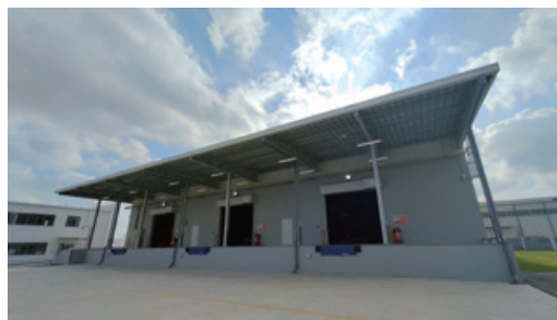
新設時の倉庫全景
