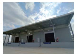
ベトナム初 日本品質の危険物倉庫
