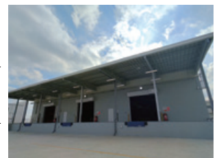
ベトナム初 日本品質の危険物倉庫
