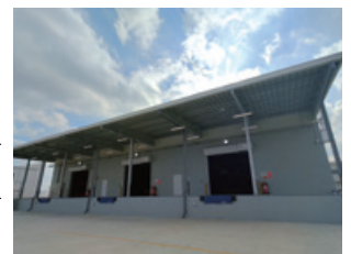
ベトナム初 日本品質の危険物倉庫
